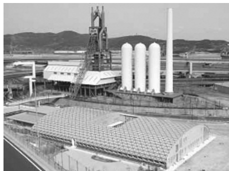
東田の高炉をバックにした 北九州イノベーションギャラリー
